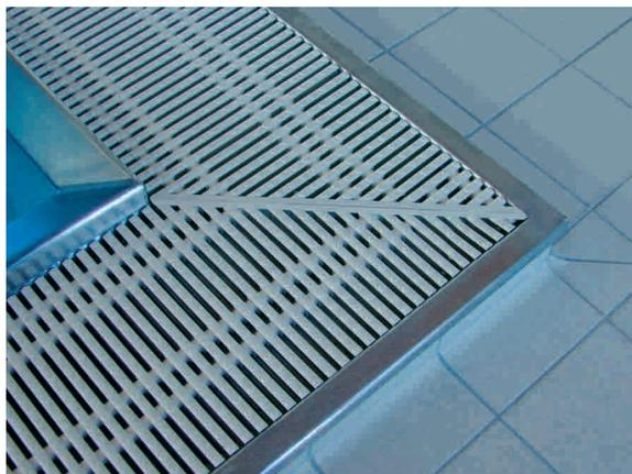
Eckverbindung auf Gehung mit stützenden Kunststoffabschlüssen (in fast allen Winkeln möglich)
